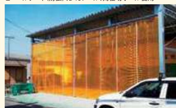
雨・風除け 防塵 防虫 ビニールシート(防虫)、D40レール、間仕切ポール使用
