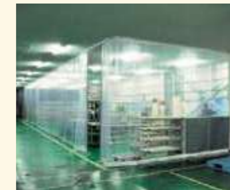
防塵 保温・保冷 ビニールシート、D40レール、間仕切ポール使用
