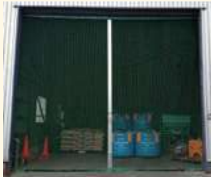
■工場出入口の防鳥ネットカーテンとして使用
