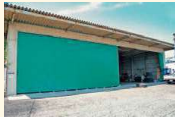
雨・風除け 防塵 テントシート、XGレール、間仕切ポール使用
