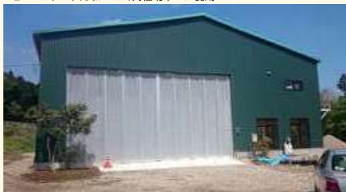
雨・風除け 防塵 ビニールシート、SGレール、間仕切ポール使用
