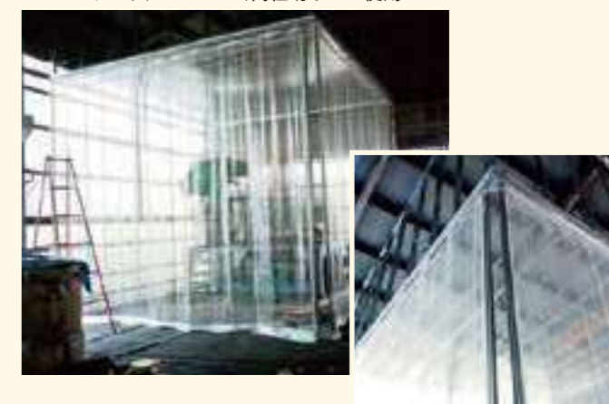
防塵 保温・保冷 ビニールシート、D40レール、間仕切ポール使用
