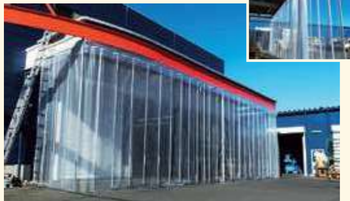
雨・風除け 防塵 ビニールシート、D40レール、間仕切ポール使用
